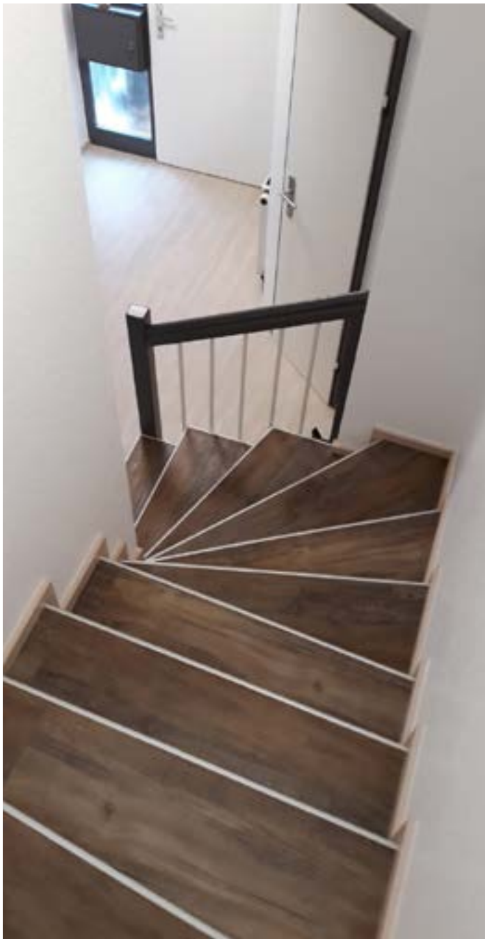
Treppenstufe mit hochwertigem ALU-Profil
